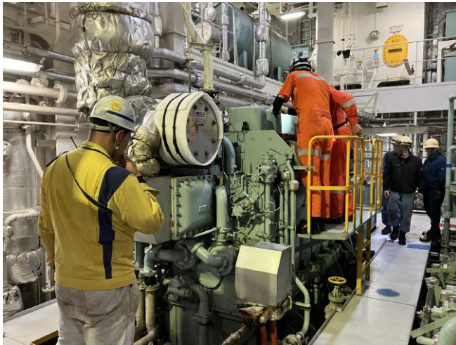
写真：機関室におけるトライアル確認の様子
